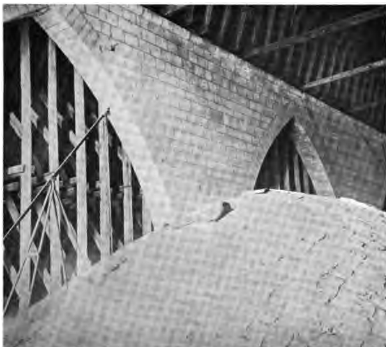
Fig. 139. — Vue prise dans le comble au-dessus des voûtes du chœur de la cathédrale de Poitiers indiquant le mode d'appareil des coupes.
